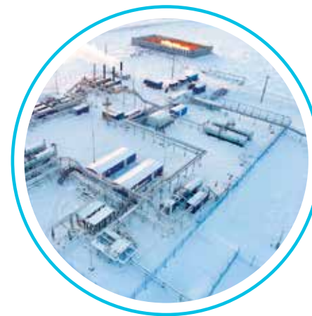
ПАО «Газпром- переработка»
